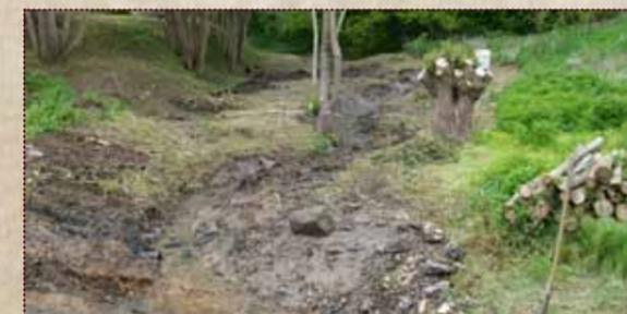
Beräumung der eingeschwemmten Sedimente und Neuprofilierung der Uferzonen
